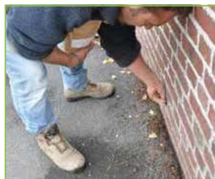
Dégager la fissure à l'aide d'un outil à dent simple, semer directement dans la fissure un mélange approprié (espèces à faible enracinement).
