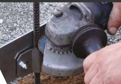
Possibilité de couper le surplus de pieu après mise à niveau
